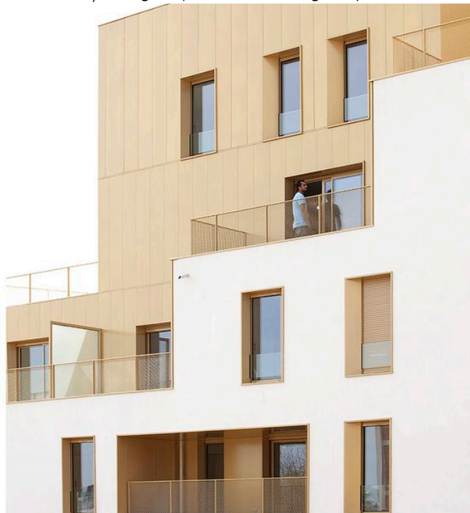
Exemple de tratări ale fațadelor, Sursa: TVK Architectes. ZAC du Chaperon Vert, Arcueil
