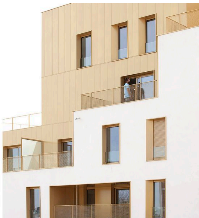
Exemple de tratări ale fațadelor, Sursa: TVK Architectes. ZAC du Chaperon Vert, Arcueil
